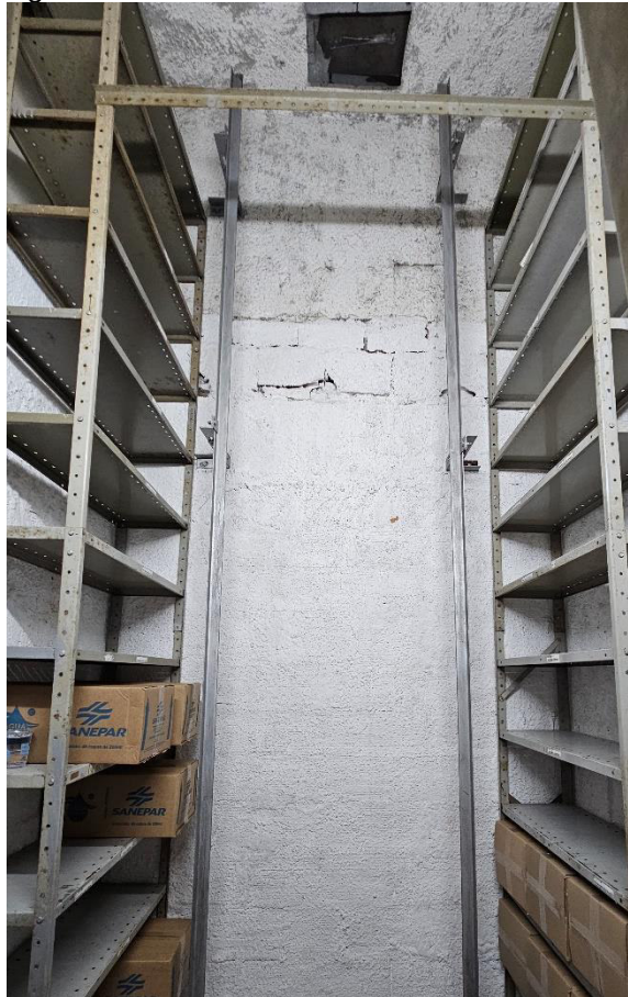
Figura 10 - Vão 5º andar
