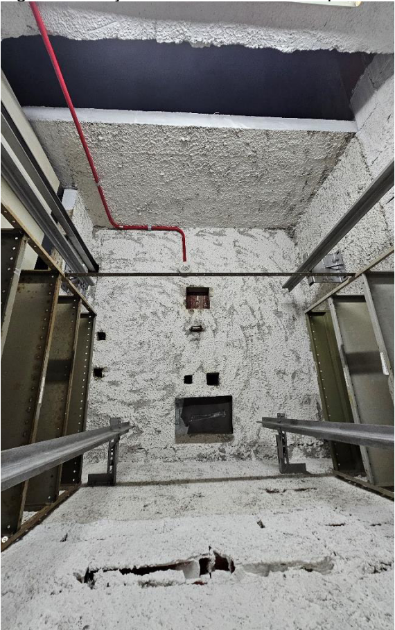
Figura 11 - Laje 5º andar e casa de máquinas
