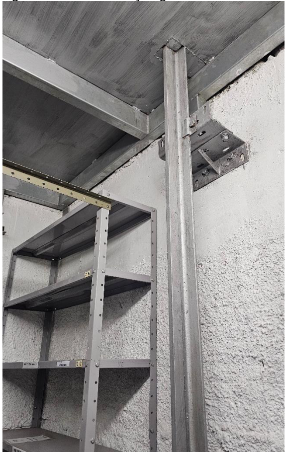
Figura 5 – Detalhe fixação guia 3º andar
