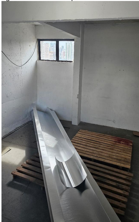
Figura 12 - Casa de máquinas
